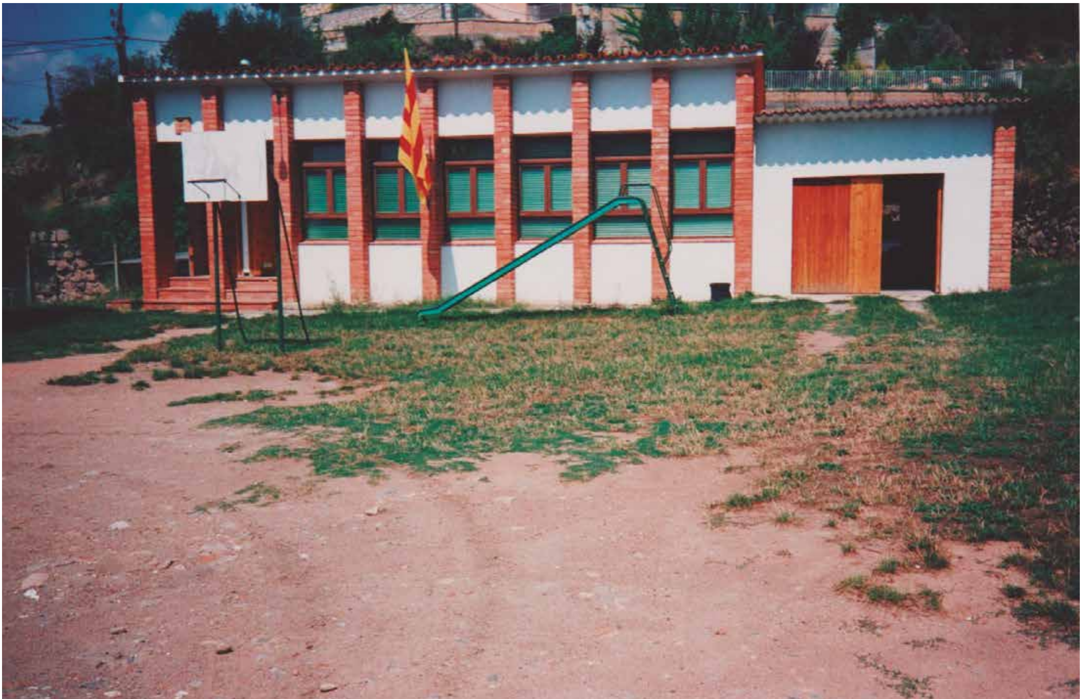
Després d'una reforma de millores per instal·lar la calefacció. Data aproximada: 1989.
