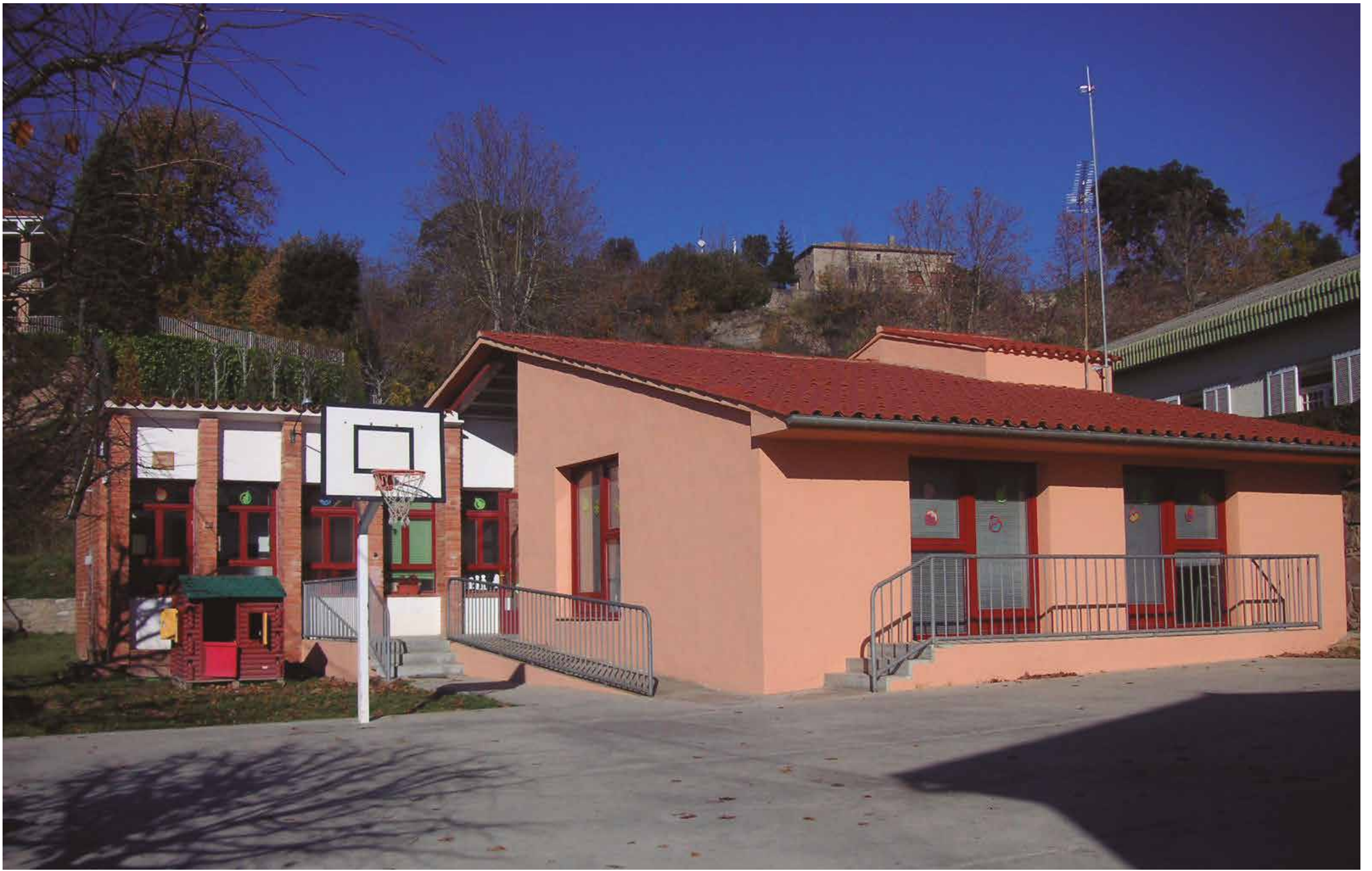
Vista del pati després de fer una pista de ciment i cistelles de bàsquet. Desembre de 2006.
