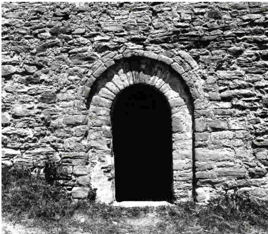
3. Porta d'accés a l'església de Sant Pere de Serrallonga, oberta a la façana de migdia. Arxiu fotogràfic de l'SPAL, núm. clixé 159.762.
