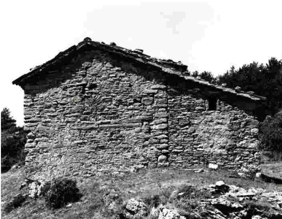
7. Façana de llevant de l'església de Sant Pere de Serrallonga, que comprèn la capçalera i la sagristia. Arxiu fotogràfic de l'SPAL, núm. clixé 159.766.
