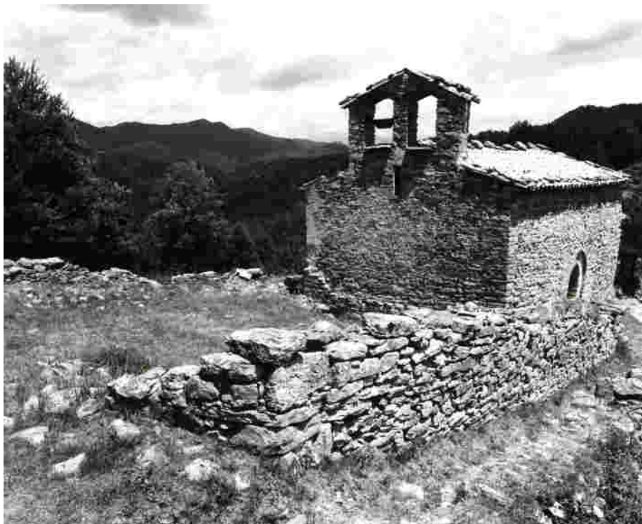
9. L'església de Sant Pere de Serrallonga vista des del sud-oest, on s'observa la tanca que s'adossava a la façana de ponent. Arxiu fotogràfic de l'SPAL, núm. clixé 159.757.
